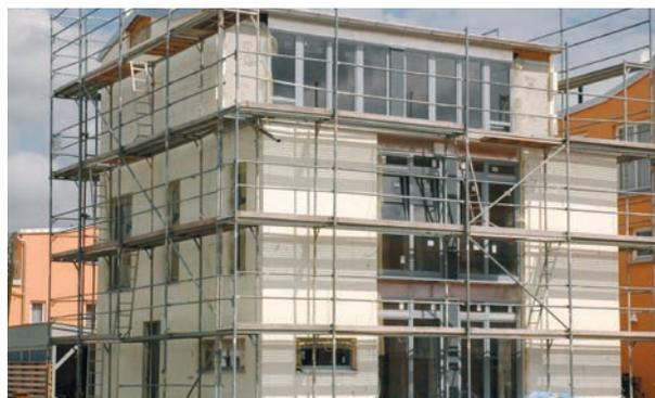
Eine gedämmte Hülle spart hohe Energiekosten, Quelle: Fachverband Wärmedämm-Verbundsysteme e. V.
